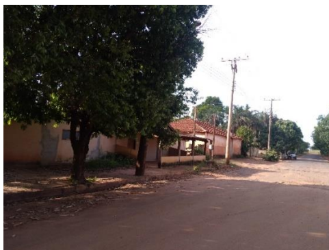
Imagem 33 - Imagem das edificações existentes
