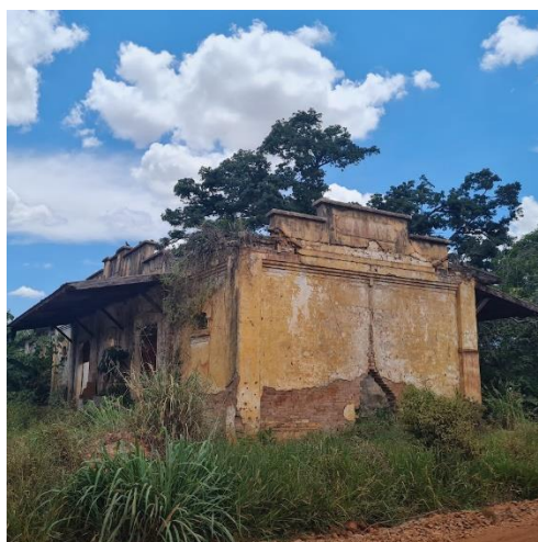
Figura 8 - Estação Ferroviária de Japurá.
